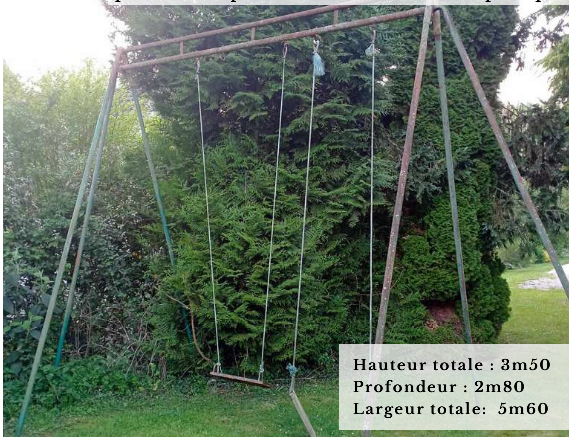
première étape de construction- base de portique
